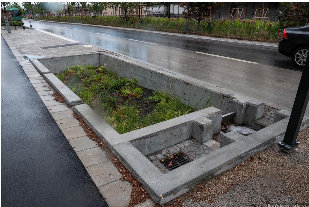
Рис. 3 Система очистки дождевой клумбы
