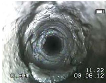
Рис. 4 – Фактическое состояние пород кровли
