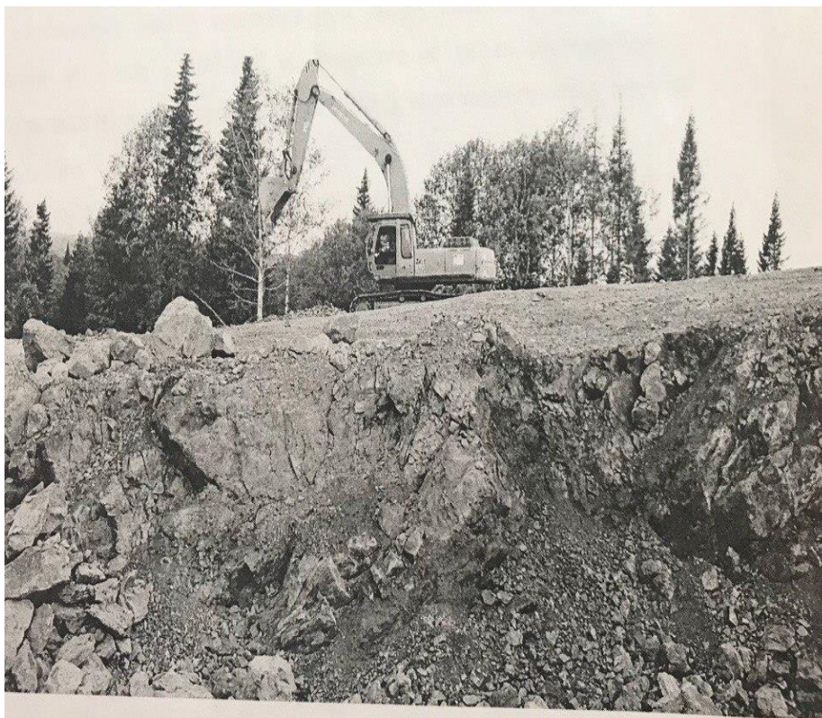
Рис. 2. Проходка магистральной канавы механизированным способом
