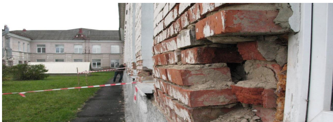
Рис. 5. Расслоение кирпичной кладки по оси В пристроенной части здания школы
