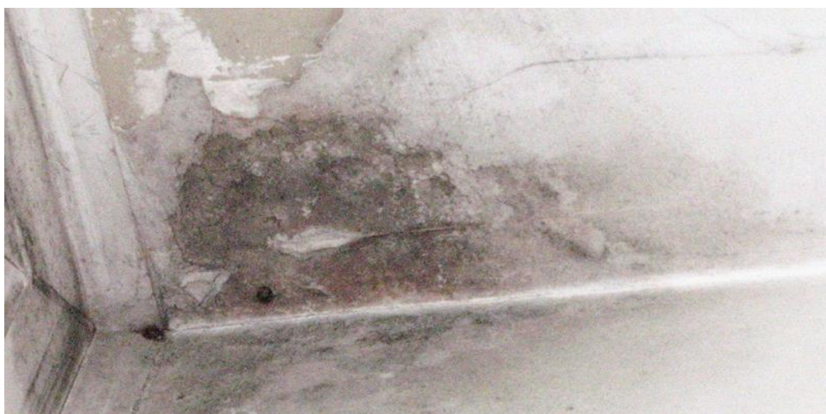
Рис. 7. Пятна постоянного увлажнения наружных стен в кабинете первого этажа
