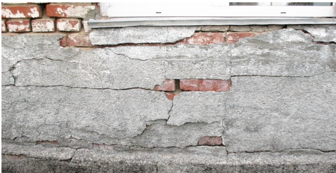
Рис. 6. Выпучивание наружной версты кирпичной кладки подоконной части здания в результате постоянного увлажнения
