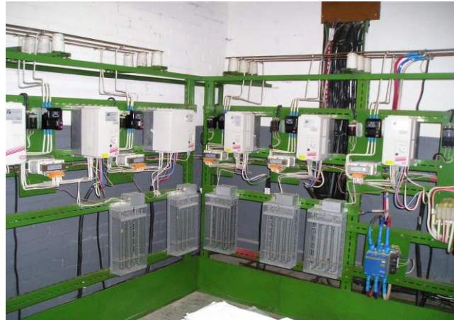
Рис. 1. Электрощитовая АСУ ЭУ промышленного предприятия
