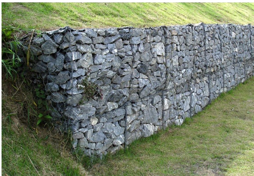
Рис. 1. Подпорная стена из габионов
