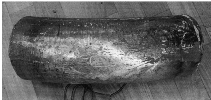
Рис. 1. Общий вид одной из рассматриваемых деталей (гиб №16 пароперепускной трубы от выходных коллекторов конвективного пароперегревателя IV ступени в паросборную камеру котла №5; Ø133,0×17,0)
