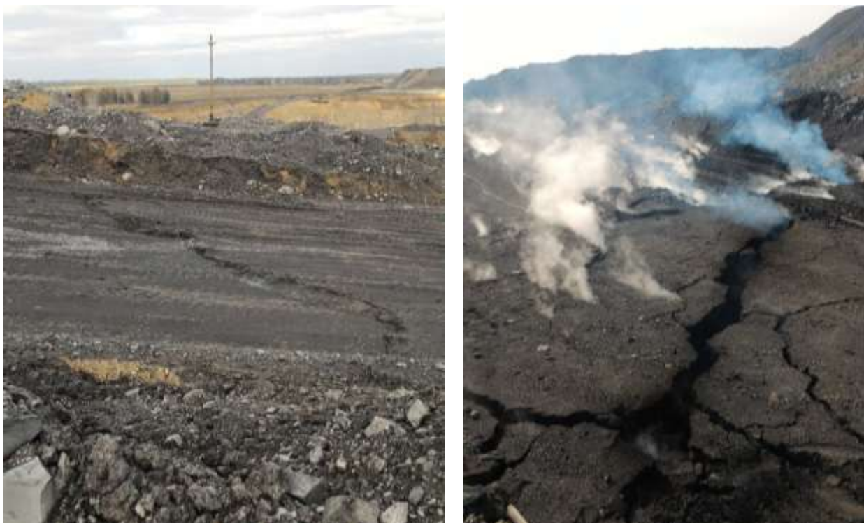
Рисунок 1: а – трещины на поверхности технологической автодороги по отвалу; б – тление отвальных пород
