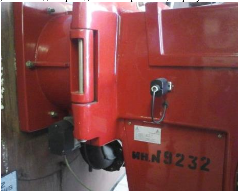
Рисунок 2. Изображение расположения датчика Siemens QRI 2B2.B180B
