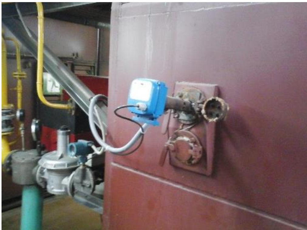
Рисунок 4. Изображение способа монтажа датчика-реле контроля пламени ПАРУС-002УФ-1Е
