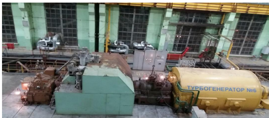
Рисунок 1. Турбина Р-50-130-1ПР1
