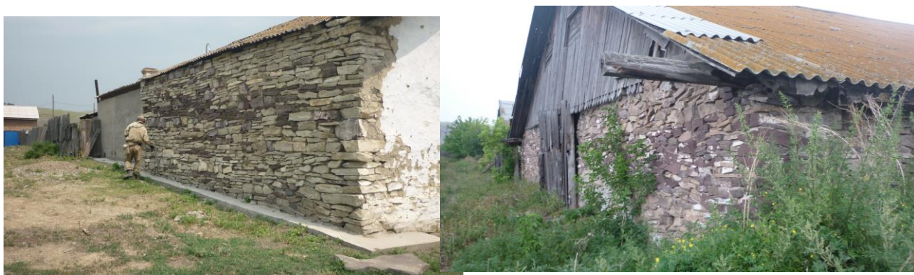
Рис. 3 Типичный вид застройки с. Кавказское: слева – радиационное обследование стеновой кладки; справа – еще одна постройка из типичного плитняка
