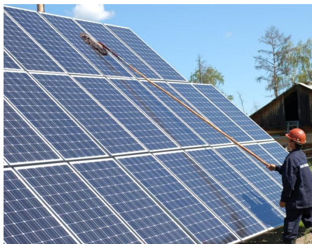
Рис. 1. Ручная очистка солнечных панелей
