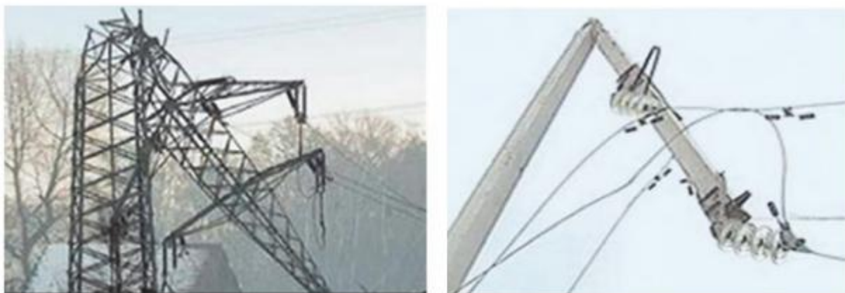
Рис. 2. Последствия обледенения ЛЭП
