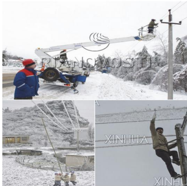
Рис. 3. Механическое удаление гололеда с проводов
