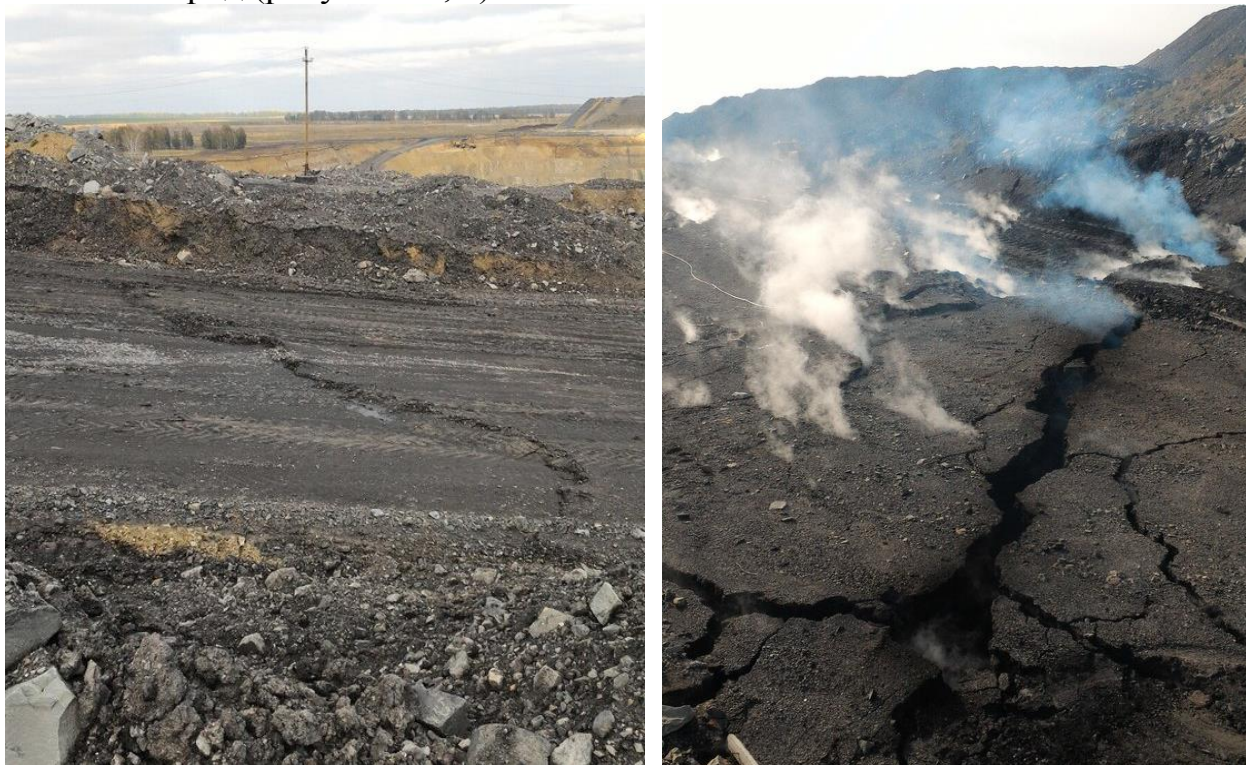
Рис. 1: а – трещины на поверхности технологической автодороги по отвалу; б – тление отвальных пород
