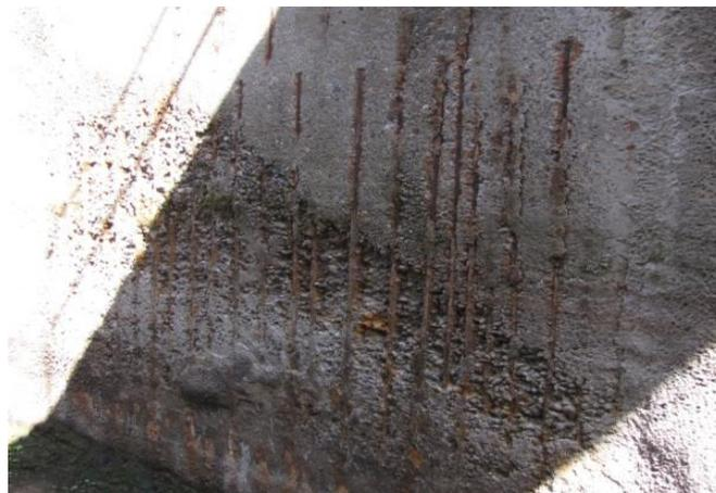
Рис. 1. Разрушение поверхностного слоя бетона и коррозия рабочей арматуры. Локальное вымывание бетона толщиной до 40 мм
