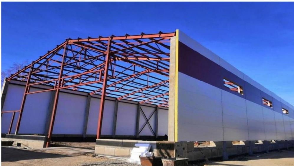
Рис. 2. Каркасное быстровозводимое здание
