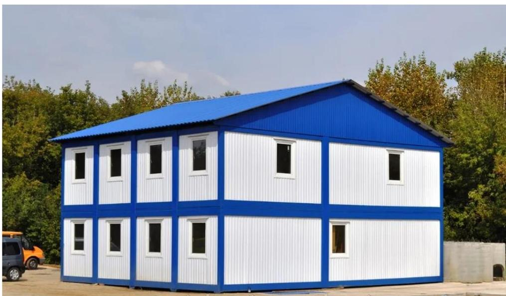
Рис. 3. Блочно-модульное быстровозводимое здание
