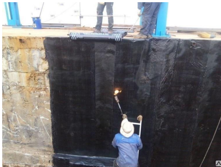
Рис. 4. Процесс монтажа рулонной гидроизоляции
