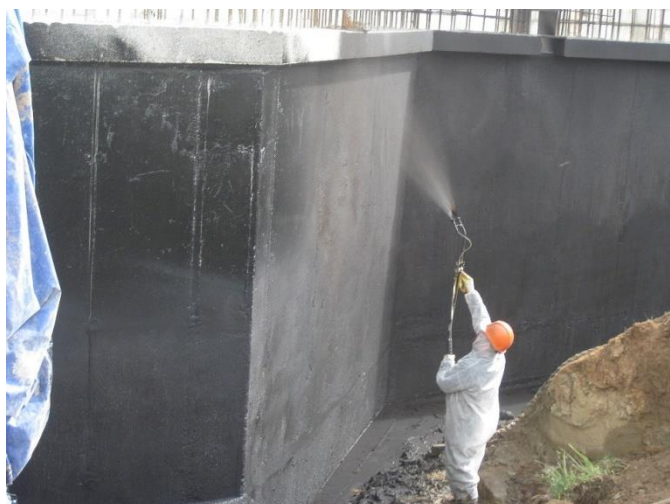
Рис. 3. Процесс нанесения напыляемой гидроизоляции
