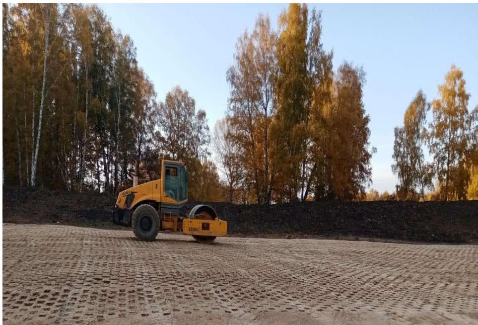
Рис. 2. Уплотнение земляного полотна
