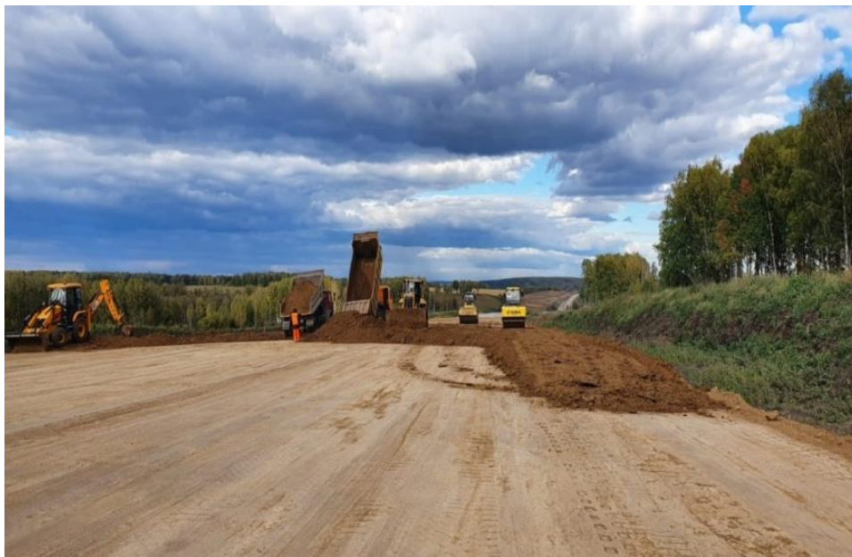
Рис. 1. Отсыпка земляного полотна
