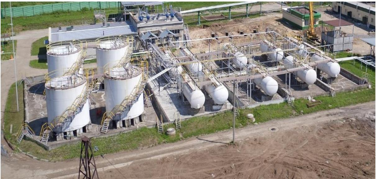
При проектировании склада проводится расчёт силы взрыва в случае возникновении искры в парах ЛВЖ при проливе, и выражается в тротиловом эквиваленте. Огромный вклад в уменьшение ущерба от взрыва вносят правильно выполненный поддон под ёмкостями с легко воспламеняющимися жидкостями, поскольку многократно уменьшает площадь испарения и, следственно, содержание взрывоопасных паров в объёме.
