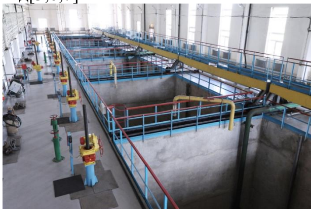
Рис 2. Отчистка шахтных вод механическим методом (осветление)
