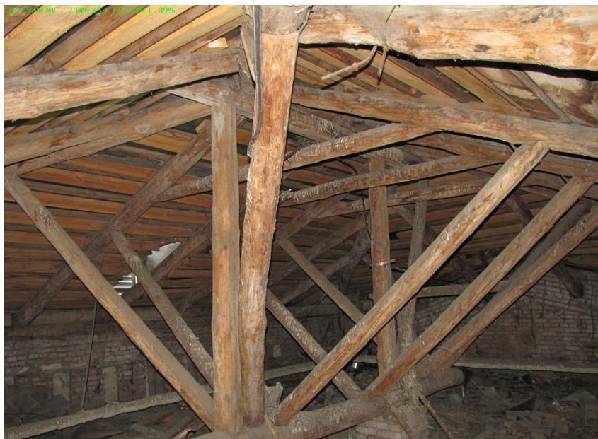
Рис. 2. Стропила блок-секции 6. Обрешетка
