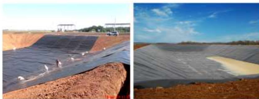
Рис. 2. Устройство гидроизоляционного экрана в основании котлована-хранилища загрязненной почвы
