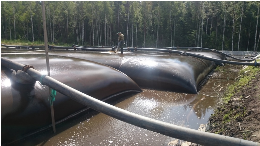
Рисунок 4.2 - Обезвоживание шлама с использованием геотубов
