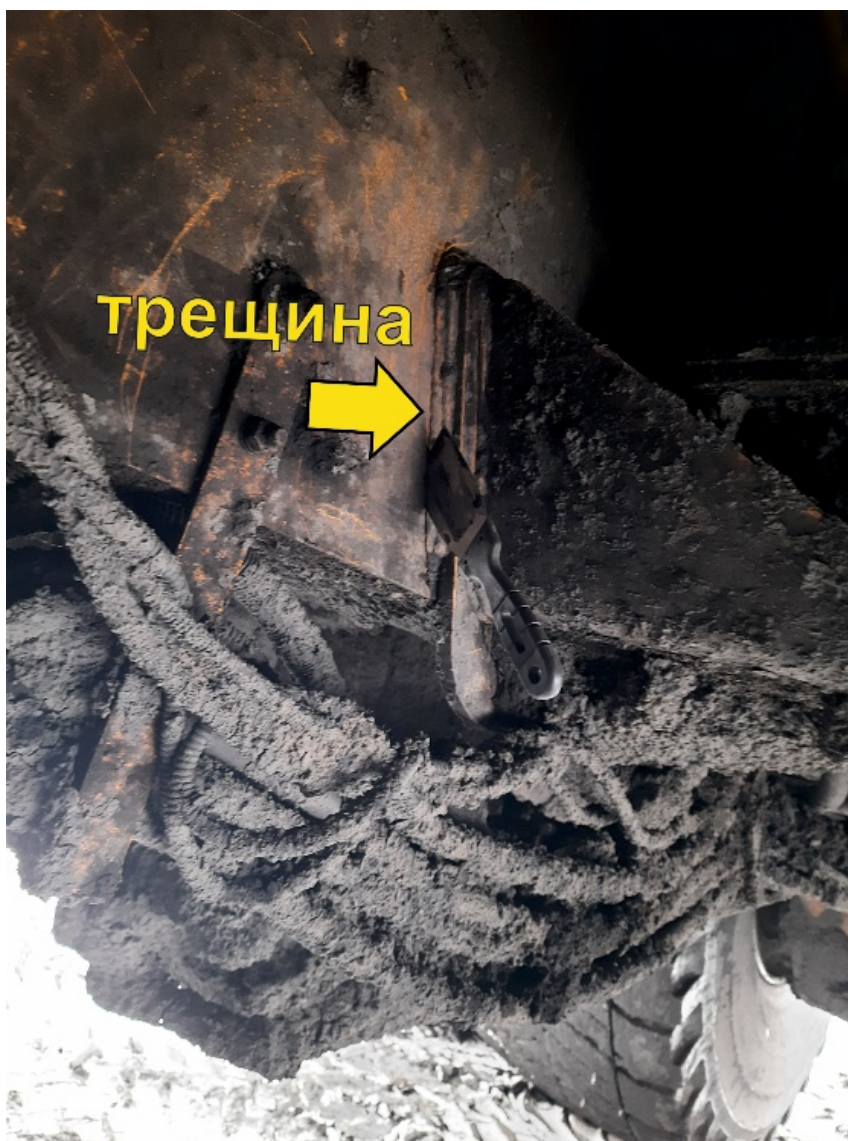
Рисунок 29. – Трещина в сварном шве
