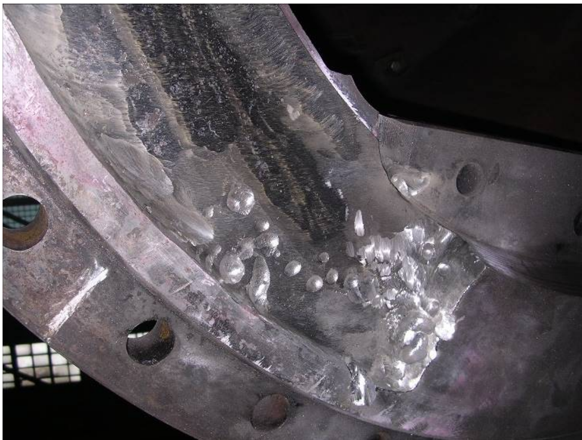
Рисунок 19. – Поверхность корпуса РМК после выборки дефектов
