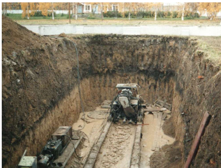
Рис 4.1. Бурошнековая машина на базе станка БГА-4 (бурение скважины под автодорогой по ул. Терешковой г. Кемерово)
