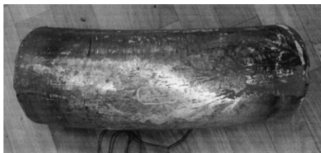
Рис. 1. Общий вид одной из рассматриваемых деталей (гиб №16 пароперепускной трубы от выходных коллекторов конвективного пароперегревателя IV ступени в паросборную камеру котла №5; Ø133,0×17,0)
