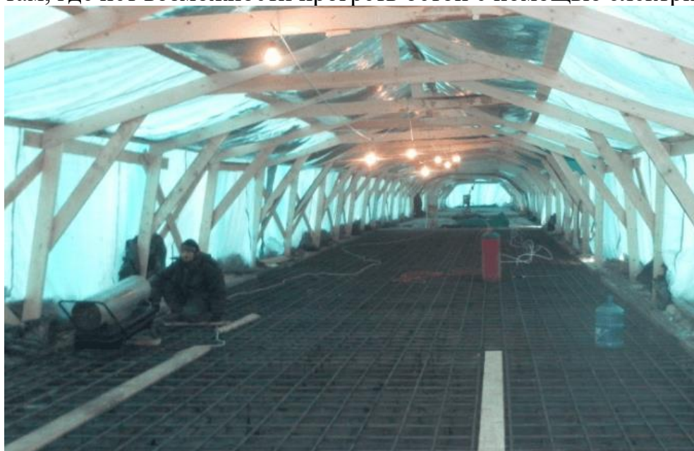
Рис. 5. Фото устройства тепляка для бетонирования плиты
