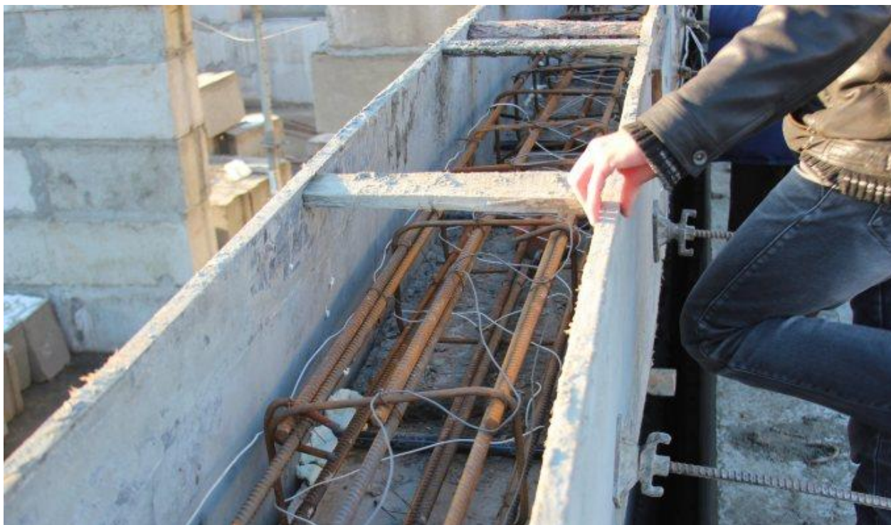
Рис.3. Фото фрагмента укладки прогревочного провода ПНСВ в опалубку
