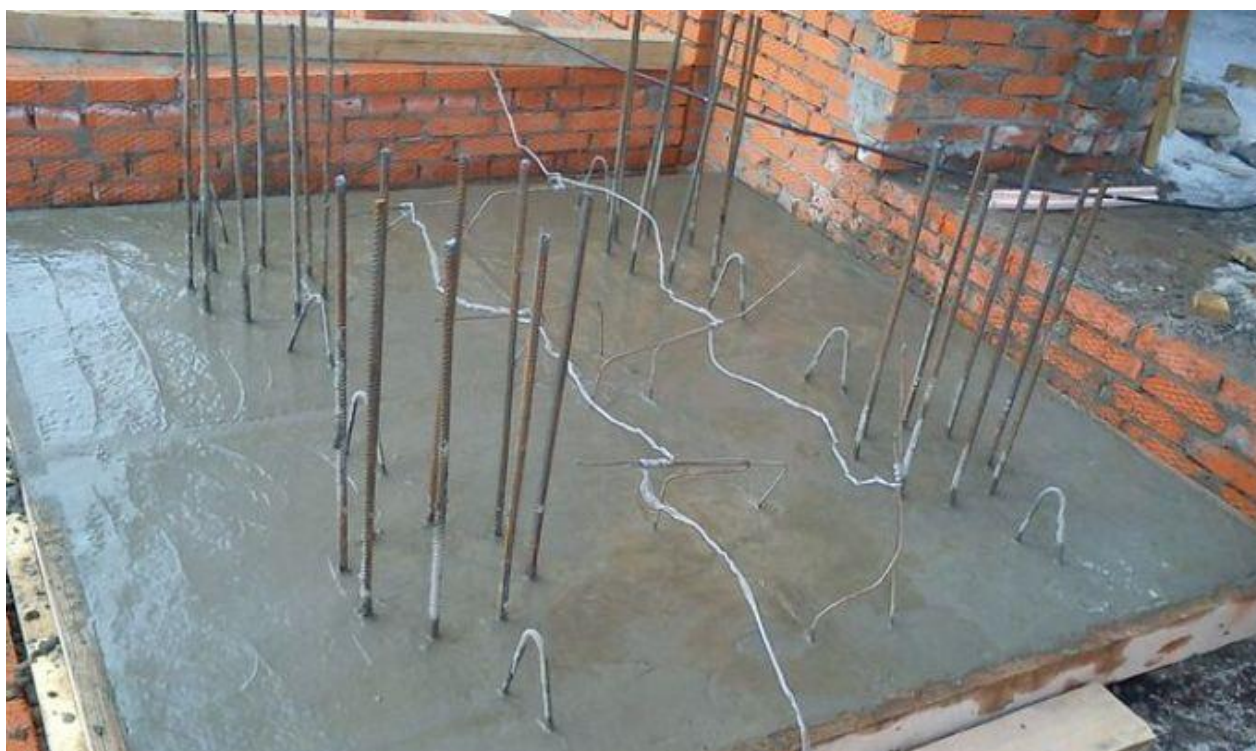
Рис.1. Фото подключения электродов для прогрева бетона
