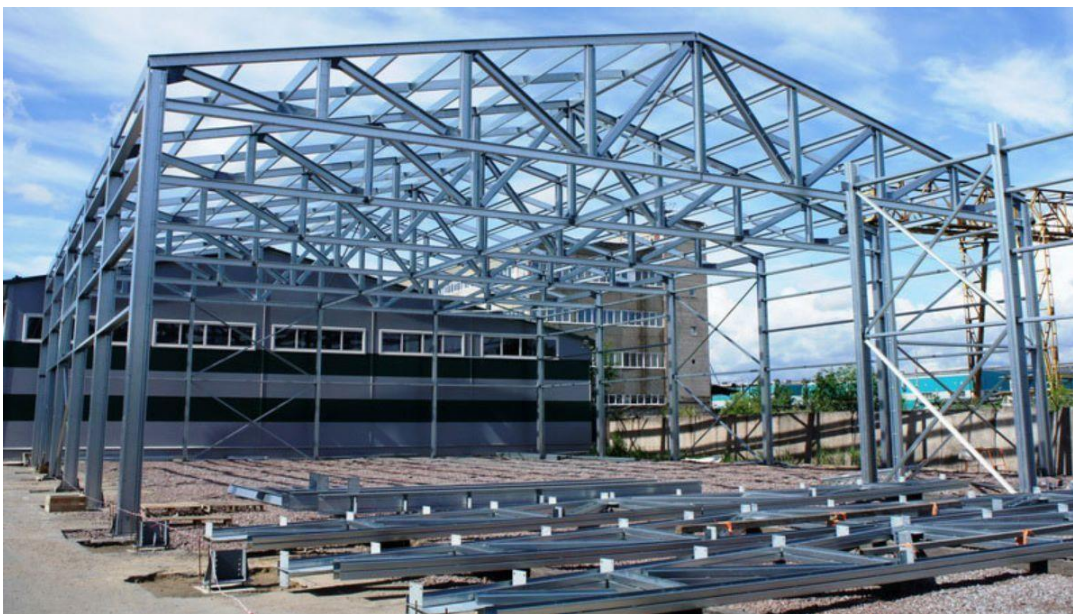
Рис.1 Монтаж каркаса ЛСТК складского помещения.
