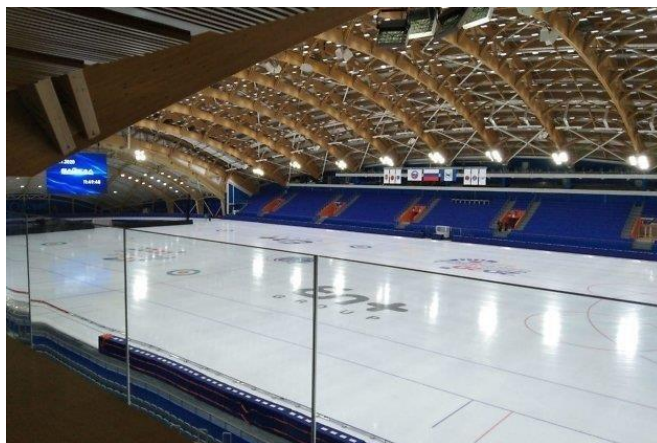
Рис. 1. Стадион «Байкал» с несущими деревянными арками.
