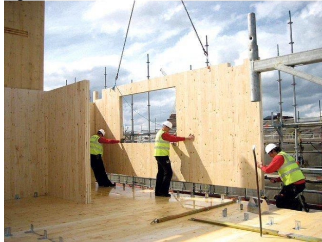
Рис. 2. Монтаж CLT-панели.
