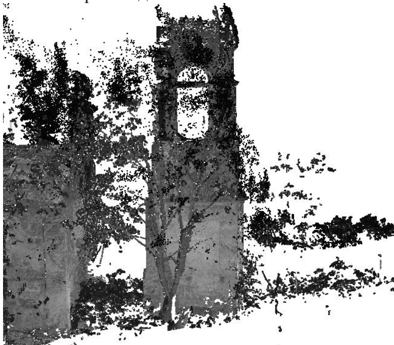
Рисунок 3 – Лишние элементы на 3д скане
