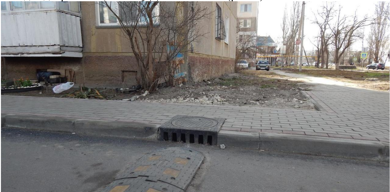
Рисунок 6 – пример устройства бордюрного дождеприемника
