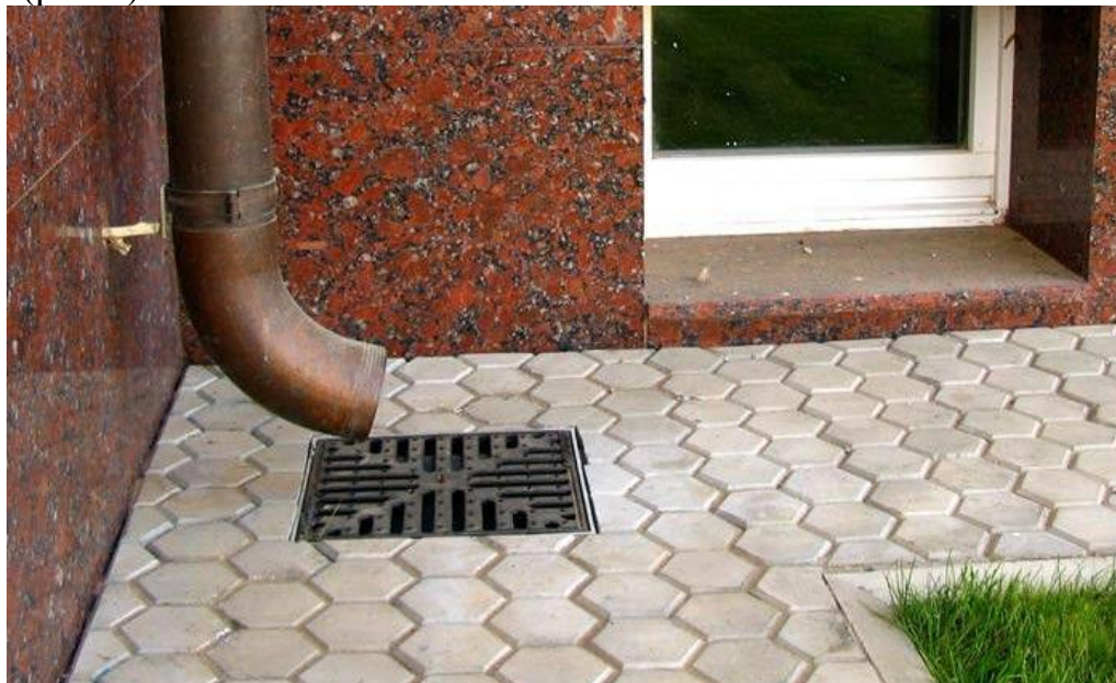
Рисунок 3 – пример расположения тротуарного дождеприемника
