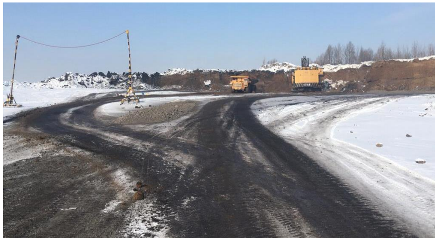
Рис.2 Забойная дорога экскаватора WK-35 № 800
