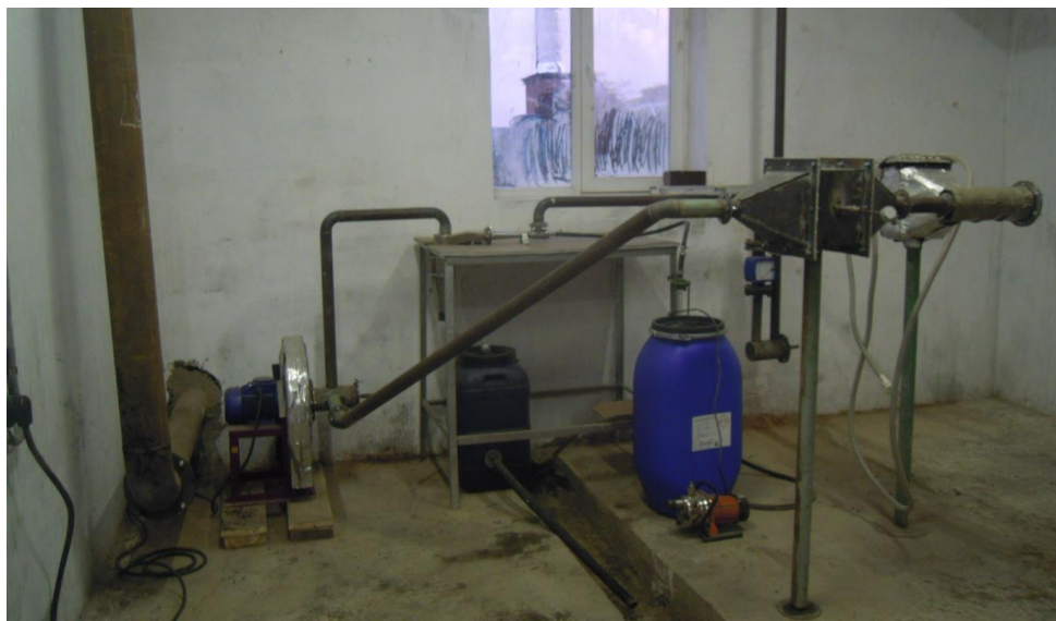
Рисунок 3 – Участок очистки дымовых газов
