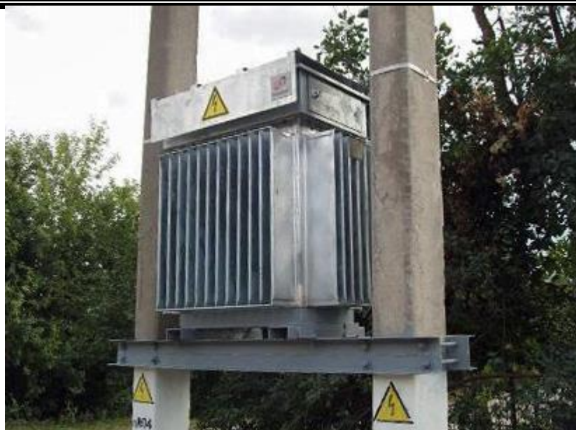
Рисунок 1. Вольтодобавочный трансформатор
