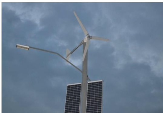
Рис. 3. Светодиодные фонари на гибридной ветро-солнечной системе на трассе М-53 «Байкал»
