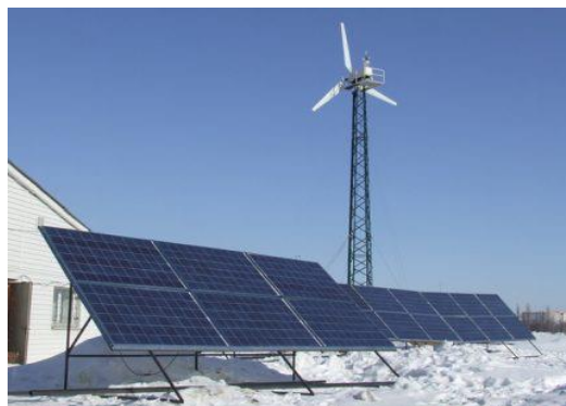
Рис. 4. Жилой дом с гибридной энергетической установкой
