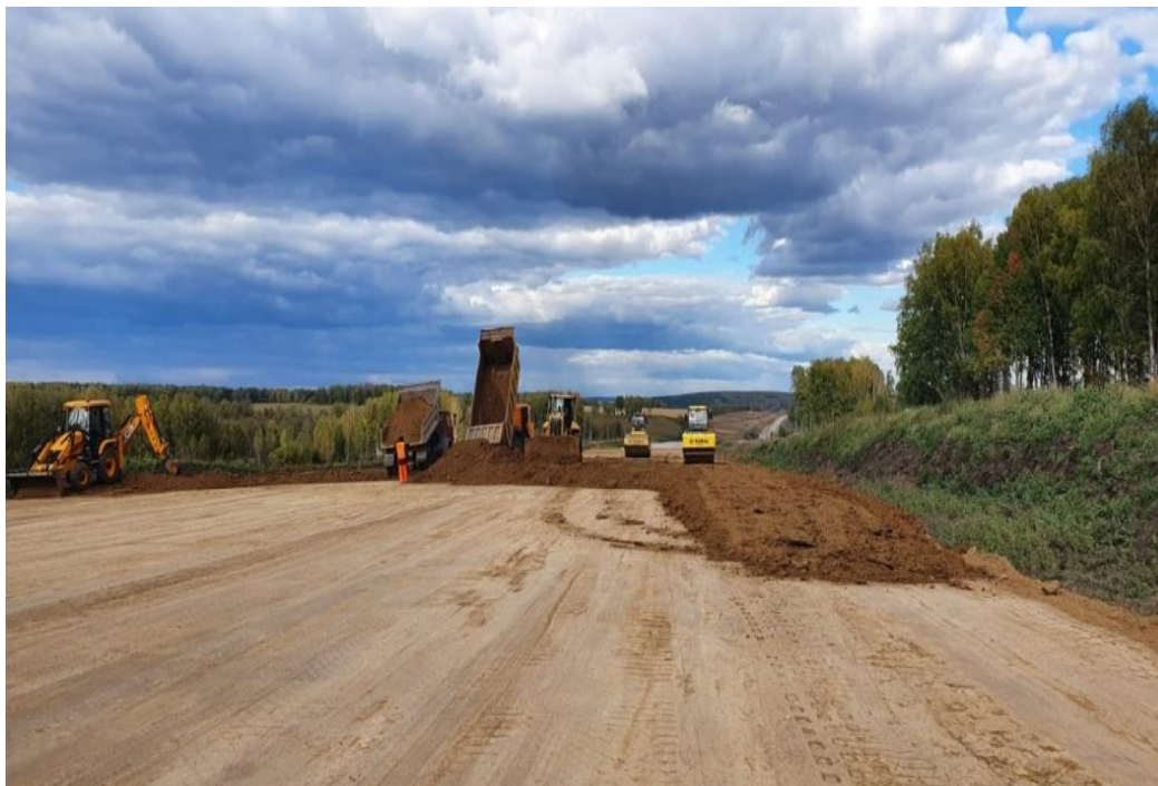
Рисунок 1 – Отсыпка земляного полотна
