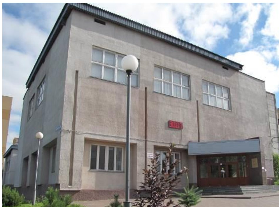
Рисунок 2 – Общий вид обследуемого здания блока 1
