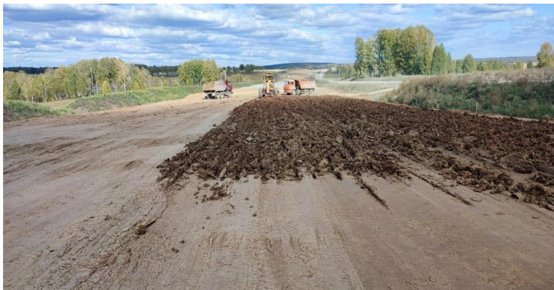
Рисунок 3 – Взрыхление, планировка и высушивание грунта
