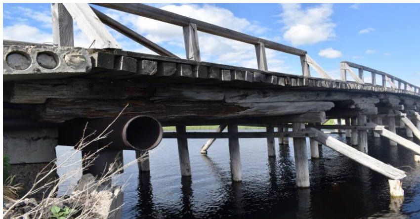
Рисунок 4 – Пролетное строение, вид с левой стороны моста
