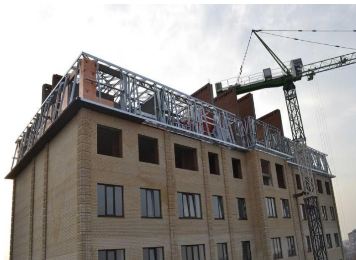
Рисунок 1 – Надстройка добавочных этажей с различным функционалом
