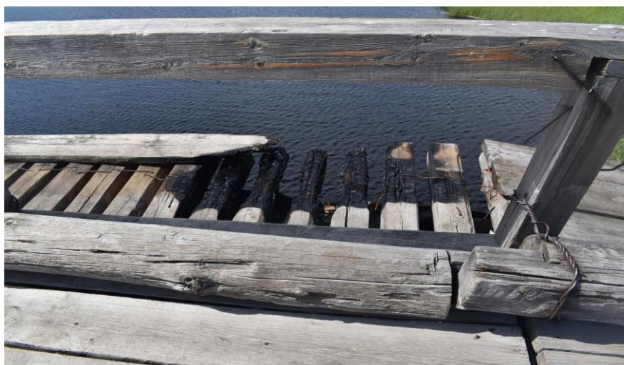
Рисунок 3 – Поперечины с правой стороны моста
