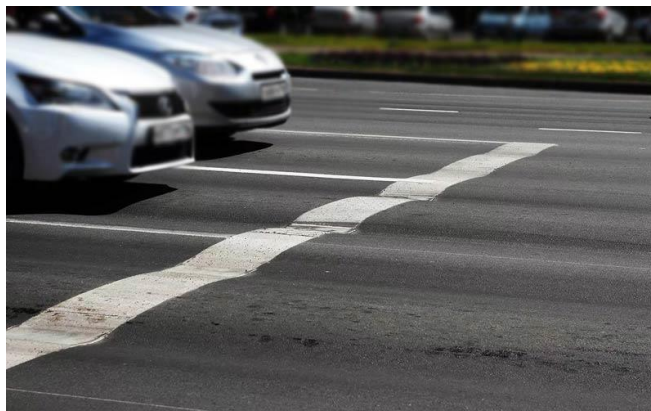
Рисунок 1 – Пример колейности
