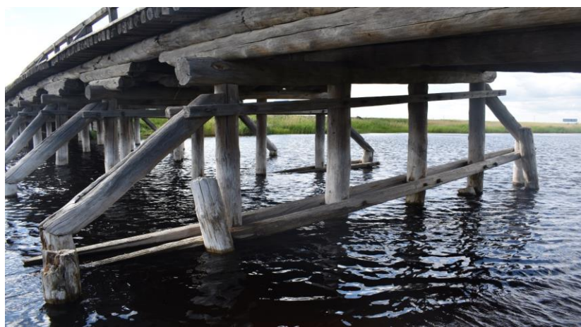
Рисунок 6 – Промежуточная опора, вид с левой стороны моста
