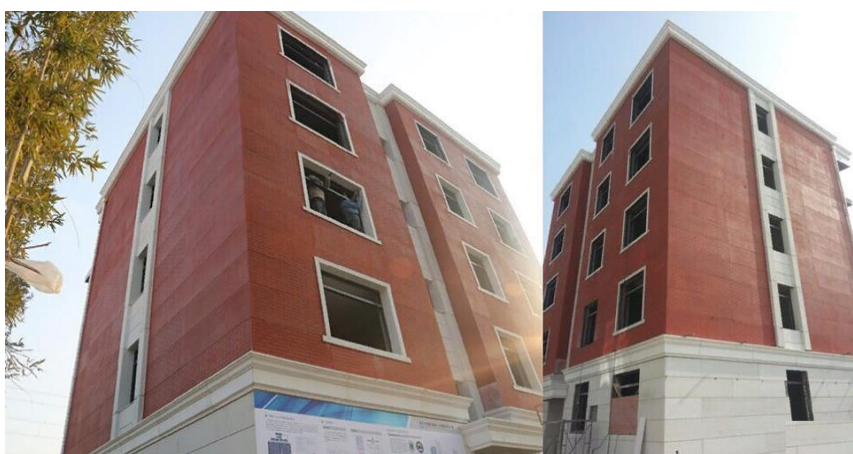
Рисунок 2 – Здание в 5 этажей, напечатанное принтером компании Winsun в Шанхае
