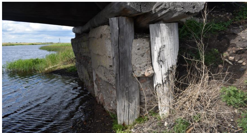
Рисунок 5 – Береговая опора, вид с левой стороны моста
