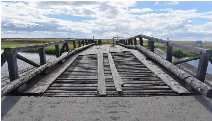
Рисунок 2 – Общий вид проезжей части, вид от начала к концу моста
