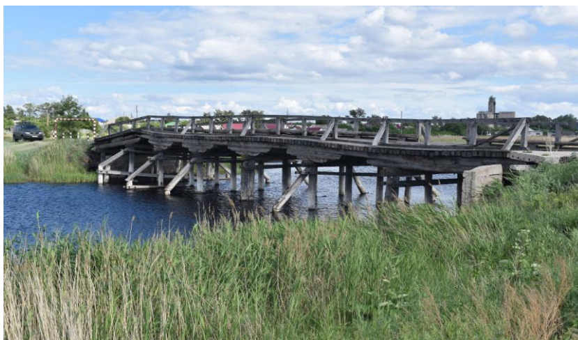
Рисунок 1 – Фасад моста, вид с правой стороны
