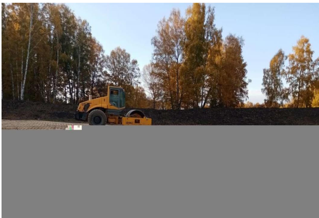
Рисунок 2 – Уплотнение земляного полотна
