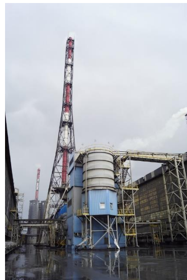
Рис. 4. Сухая газоочистка АО «РУСАЛ Новокузнецк»
